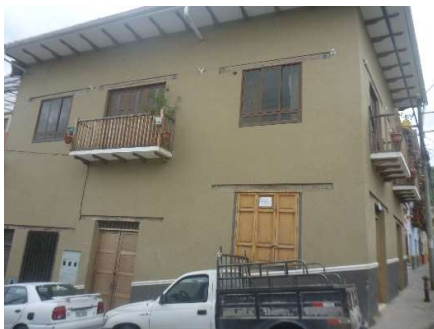
CASA DE ARRIENDO SIGSIG
