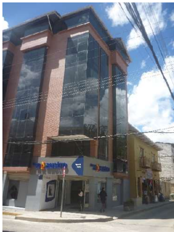
BANCO DEL AUSTRO CENTRO DE SIGSIG
