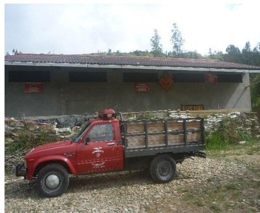
BODEGA FUEGOS PIROTECNICOS ZHUZHO
